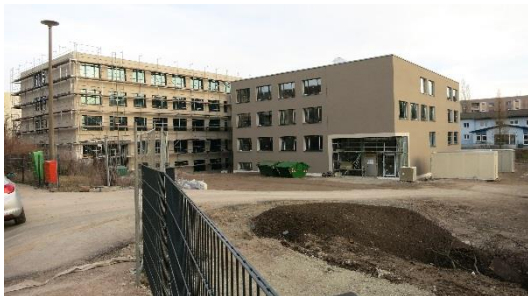
Ansicht zum Bautenstand 18.03.2015
